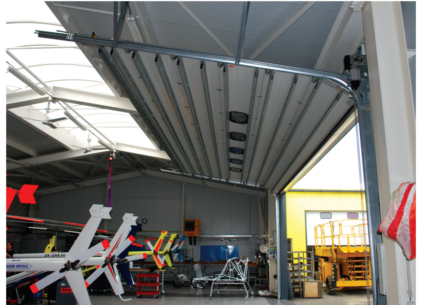
FSL Standardführung mit Dachfolge von 15°
